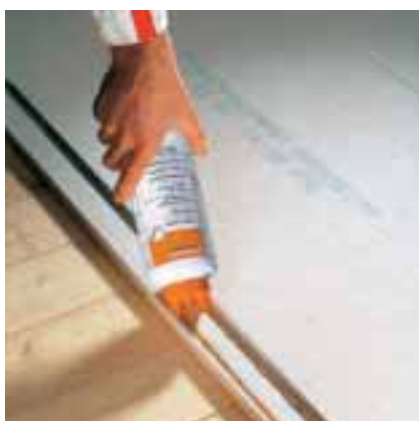
Incollare le battute con l'adesivo per sottofondo FERMACELL
