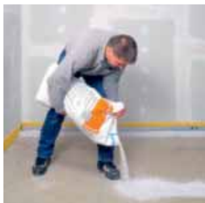
Fig. 2 – Getto delle "strisce d'appoggio" iniziali
