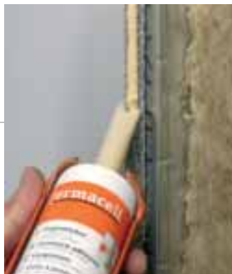
Applicare l'adesivo per giunti FERMACELL al centro del bordo della lastra
