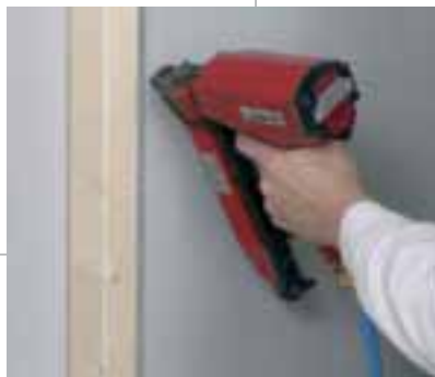
Fissare con graffe o viti alla sottostruttura
