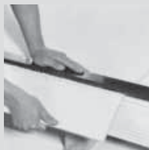
c. Rottura lungo la linea di incisione
