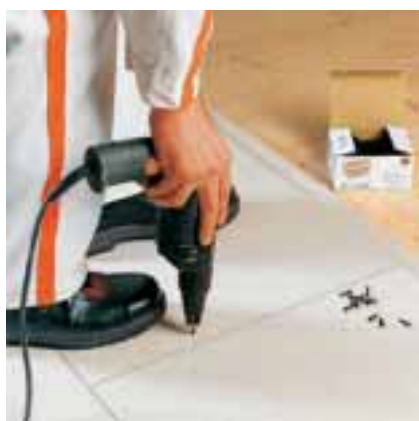
Fissare con le viti ...
