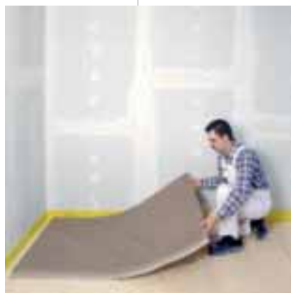
Posare FERMACELL nido d'ape
