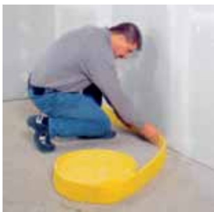
Fig. 1 – Posa delle strisce perimetrali isolanti
