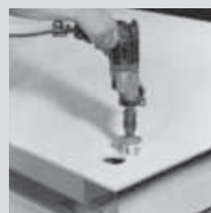
h. Fresatura fori per installazione/passaggio impianti
