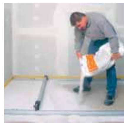
Fig. 3 – Riempimento con il livellante granulare
