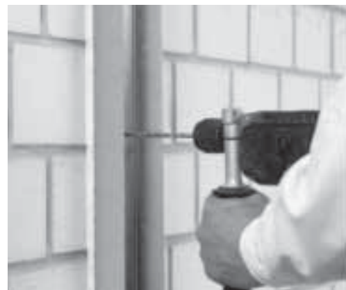
b. Fissaggio dei montanti a "C" su parete piena previa posa di strisce perimetrali isolanti
