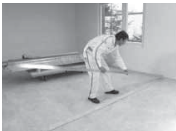
a. Posa delle guide a "U" sul pavimento su strisce perimetrali isolanti
