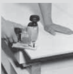
e. Taglio con seghetto elettrico alternativo
