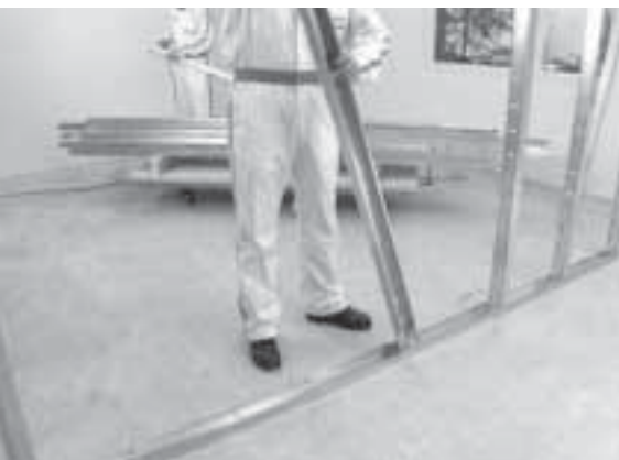
c. Montaggio dei montanti a "C"
