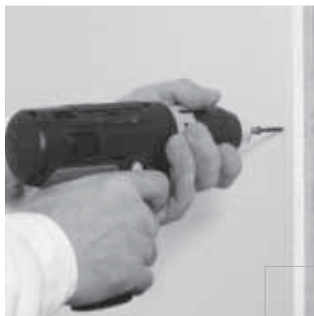
Viti su sottostruttura di metallo
