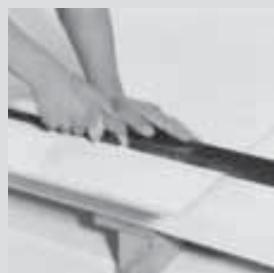
b. Incisione della linea di taglio con FERMACELL tagliastre
