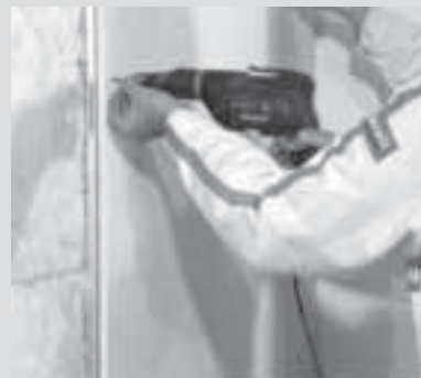
Fissaggio con avvitatore
