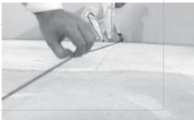
Definizione dell'asse di allineamento della parete con corda o tracciatore laser per edilizia
