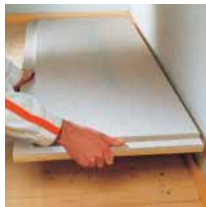
Posare le lastre per sottofondo FERMACELL
