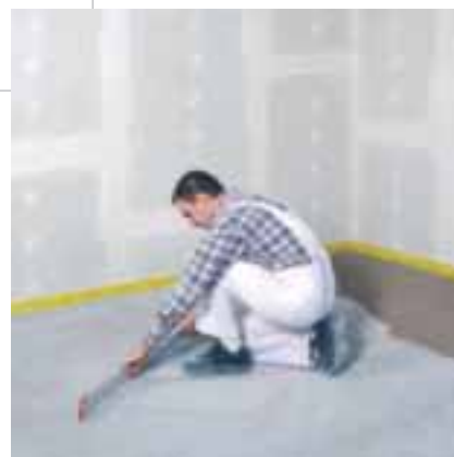
Livellare a raso del nido d'ape il granulare di riempimento FERMACELL
