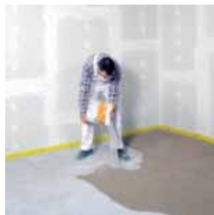
Posare FERMACELL riempimento per nido d'ape
