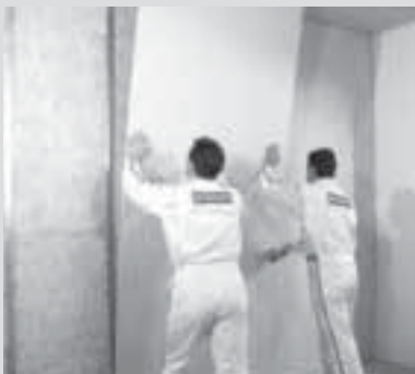
Tamponamento della sottostruttura metallica
