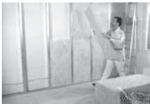
Applicazione del materiale isolante
