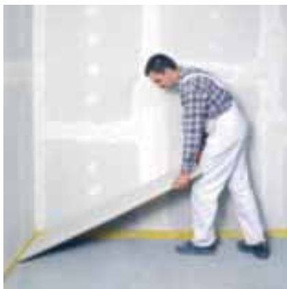
Posa delle lastre per sottofondo FERMACELL
