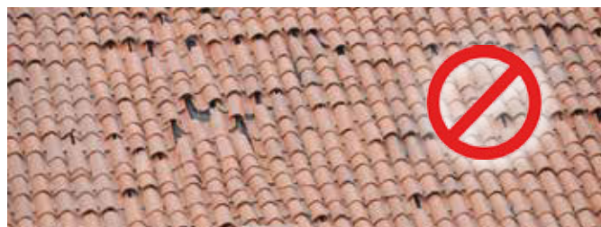
Posa dei coppi senza i ganci per l'ancoraggio
