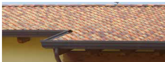
Posa dei coppi con i ganci per l'ancoraggio
