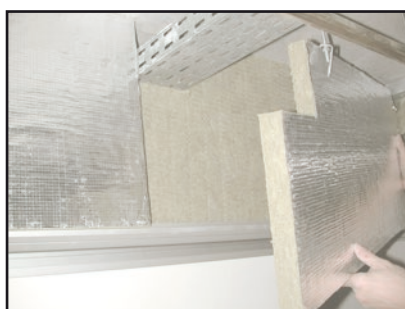
Soundstop 30 dB è un doppio pannello sfalsato (30 mm + 30 mm).
